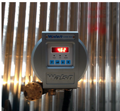
OAM-800 现场照片
